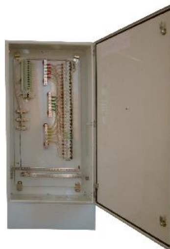
ЩУ Узола Щит частотного регулирования привода
