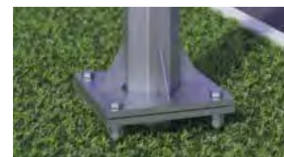
Фланцевое соединение
