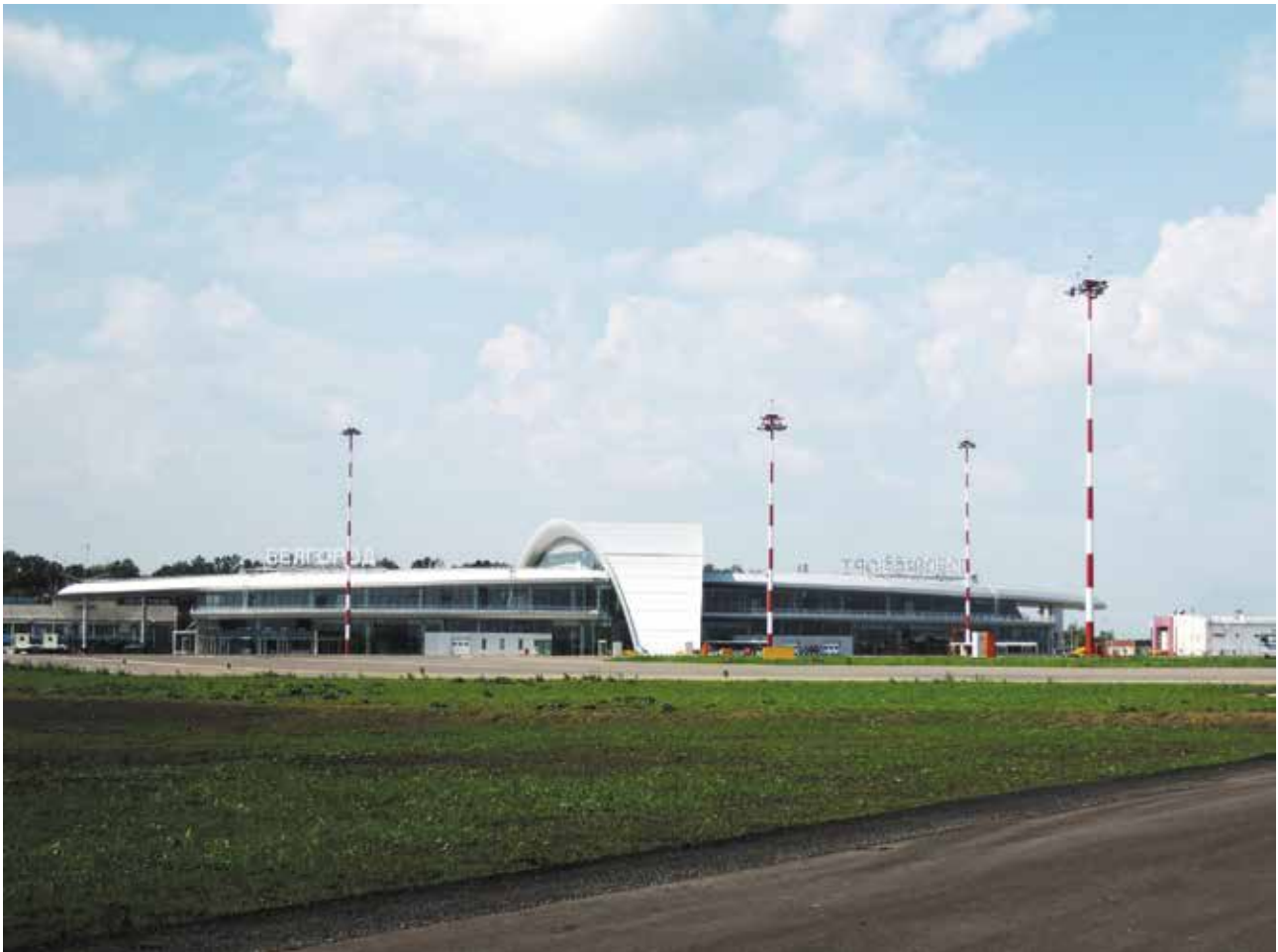
Функциональное освещение перронов аэропорта Белгород. Мачты специальные с дневной маркировкой с рабочими и аварийными прожекторами и огнями ЗОМ.
