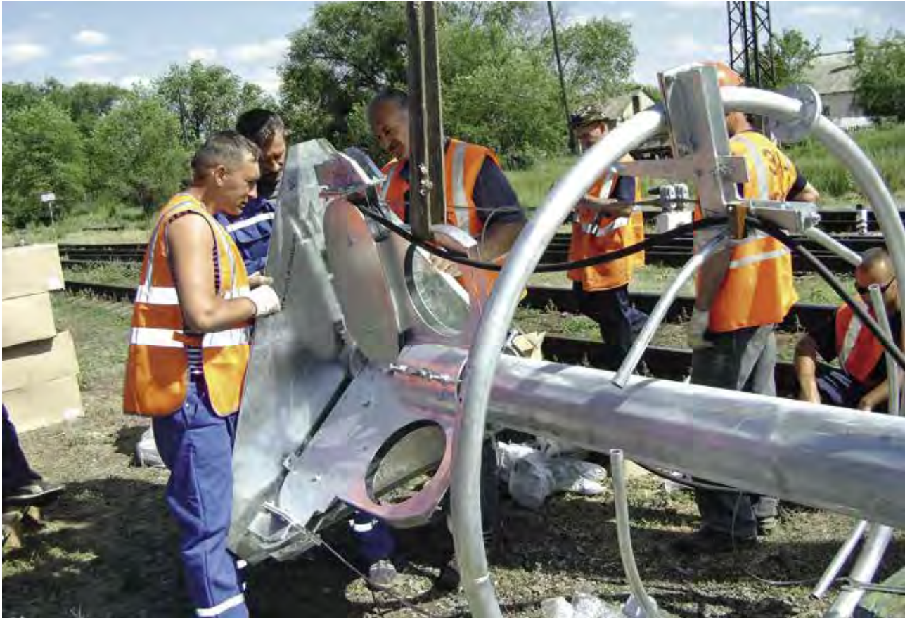
Монтажный комплект Используется при монтаже мачт различного назначения
