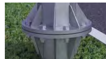
Фланцевое соединение
