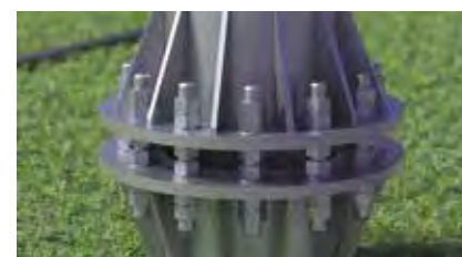
Фланцевое соединение
