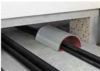
Расположение проходки в отверстии проходки.
