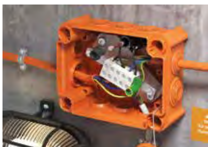
Ввод кабеля с помощью уплотнителей.
