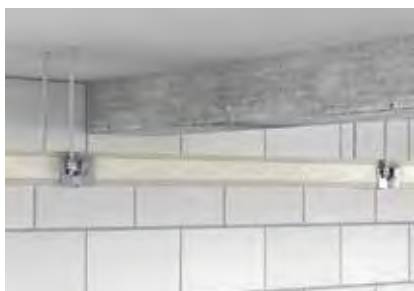
Подвесной монтаж на соединительных элементах.
