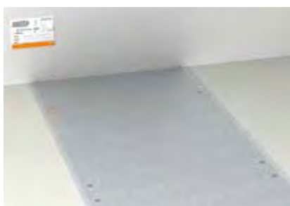
Невидимая проходка в каналах под бесшовным полом.
