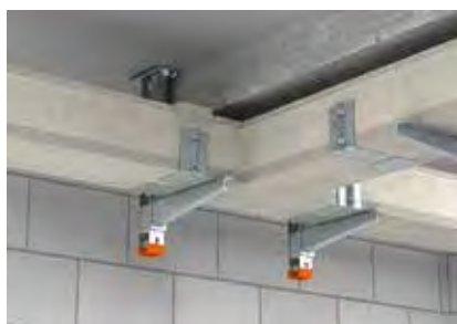
Предварительно смонтированные стандартные фасонные детали в трассах.
