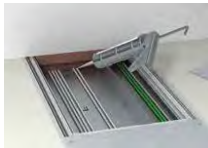
Заделать стыки шпатлевкой FBA-SP.
