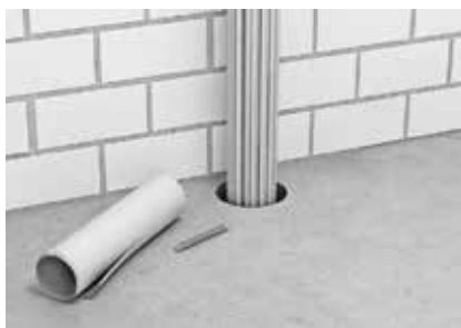
Подготовка кабельной проходки.
