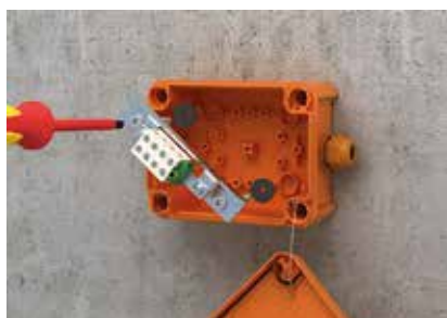
Настенный монтаж огнестойкой распределительной коробки FireBox.
