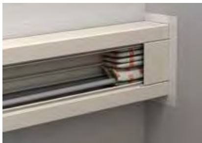
Расположенные в кабельном коробе подушки.
