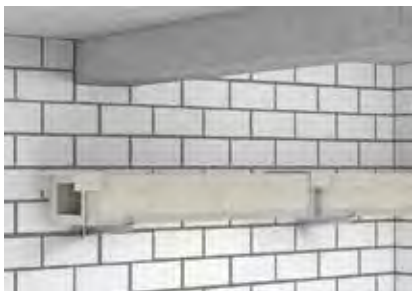
Настенный монтаж в качестве короба класса I.
