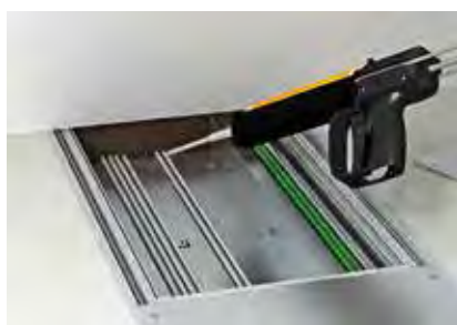
Нанесение огнестойкой пены непосредственно под стену.
