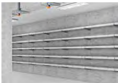
Кабельный туннель с бандажими в силовых установках.
