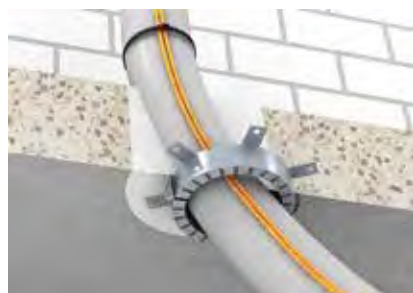
Трубы пневмопочты с двумя сопутствующими кабелями.
