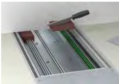
Подогнать пеноблоки по размеру с помощью ножа.
