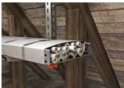
Бандажированная кабеленесущая система в областях с большим количеством легко воспламеняющихся материалов.
