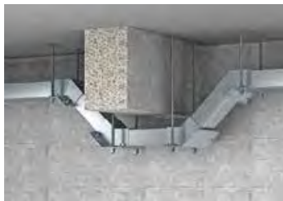
Потолочный монтаж с вертикальными угловыми секциями.
