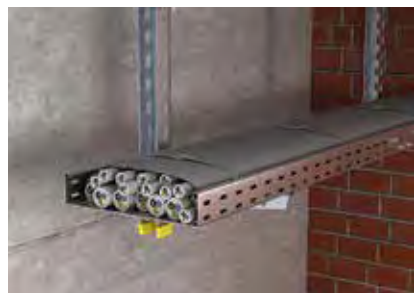
Бандажирование кабельного пучка на несущих системах.
