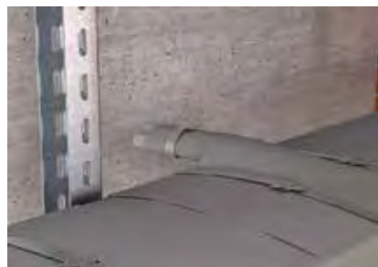
Кабельный вывод с бандажированием.
