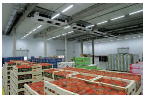
Использованы светильники ДСП52-32-101 Optima. Езкс>200лк Для дежурного освещения использован светильник ДБ086-12-041 WМ EM1
