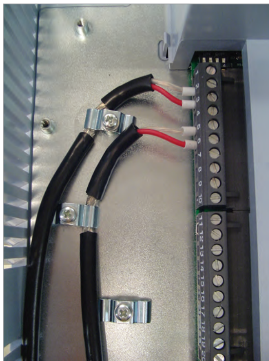
Рис. 3.20 - Пример подключения экрана для управляющей проводки
