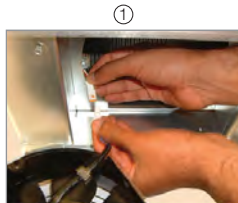
① Verbindung der Kabel
