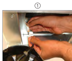
Connexion des câbles
