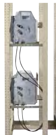
Блокировка двух выключателей Masterpact гибкими тросиками
