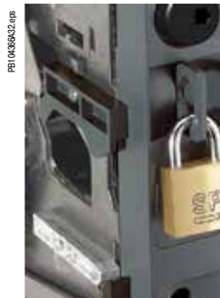
Блокировка в положении «выкачено» встроенным или навесным замком
