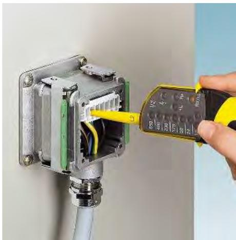
Многослойные контактные вставки позволяют подготавливать питающие линии для модульного машиностроения и производства оборудования. Затем на месте монтажа можно просто, быстро и надежно подсоединить многослойные контактные вставки к распределителям энергии.
